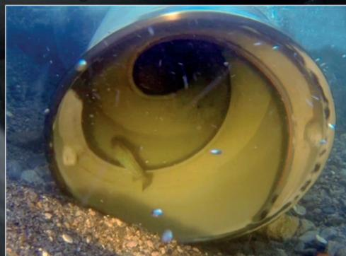
Blick ins Außenrohr mit elliptischer Ausformung des Schneckenflügels
