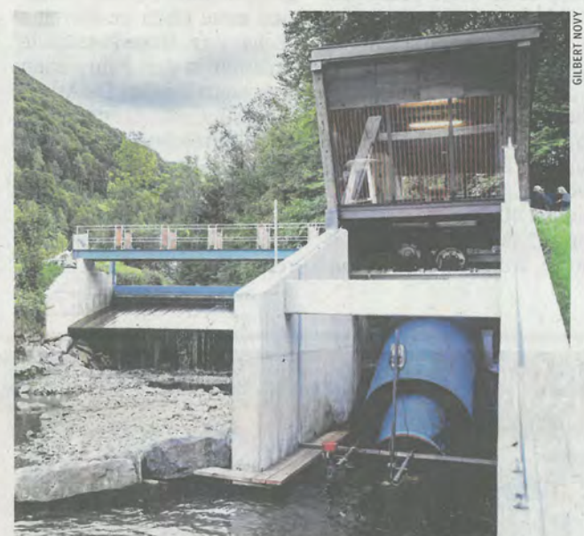
Der Fischlift transportiert die Fische sanft von unten nach oben
