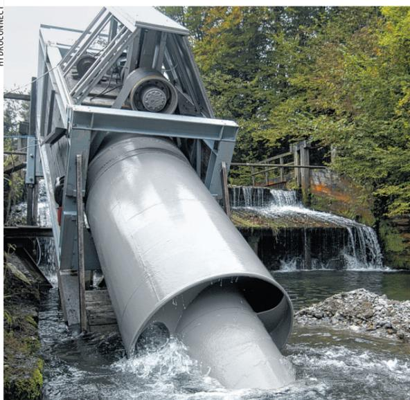
**Der Lift für Fische: Doppelrohrschncke wird im Einsatz getestet**
