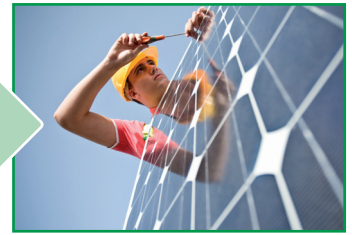
Fertigung, Ballastierung und Verkabelung der Einheiten
