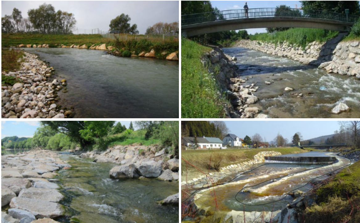
Abbildung 48 Asymmetrische Rampe: Flutmulde Machland (o.l.), Mündung Liesing (o.r.); asymmetrische Raugerinne: Ybbs bei Amstetten (u.l.) und Michelbach bei Furth (u.r.)
