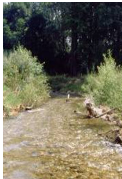
Abbildung 23 Gewässertypspezifisches Umgehungsgerinne vom Gewässerbett völlig abgesetzt, dynamisch dotiert
