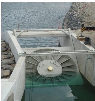
Abb. 15: VLH-Turbine (Quelle: MJ2 Technologies S.A.S. / Stellba Hydro GmbH & Co KG)
