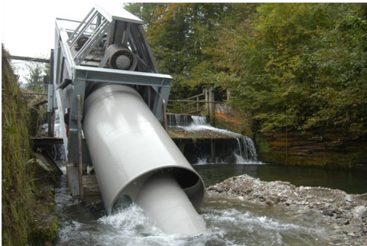
Abb. 31: Drehrohr-Doppel-Wasserkraftschnecke (Quelle: Fa. Hydroconnect)
