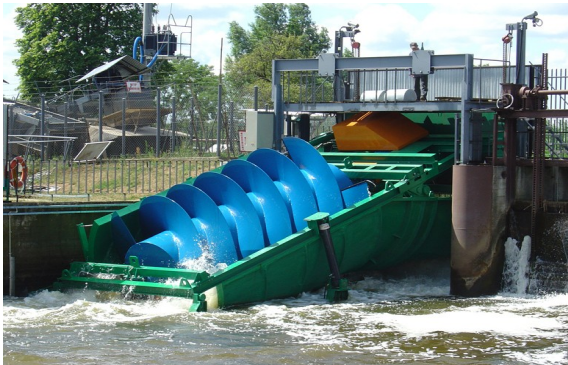
Abb. 29: Wasserkraftschnecke
