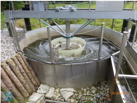
Abb. 21: Pilotanlage des „Fischfreundlichen Wehrs“ in Bühlau/Sachsen (Quelle: J. Signer, SMUL)
