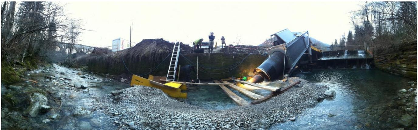
**Abb. 1 - Panoramafoto des Prototyps mit Unterwasserabsperung - Dammschüttung und Auslassöffnung mit Rechengitter**
