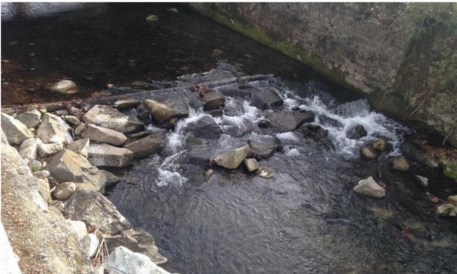
*Abbildung 2: Querbauwerk (Schwelle) – Anrampung unterwasserseitig mit grobblockigen Material*
