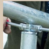
Die Schraubverbindung mittels des Sechskant-Steck-Schlüssels und einer Ratsche festziehen und die beiden Elemente somit endgültig fixieren.
