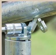
Anhand der mitgelieferten Schraube und Mutter die Plättchen des Mantelverbinders sowie den aus dem Steherrohr herausragenden Teil des Stirnberbinders verbinden.
