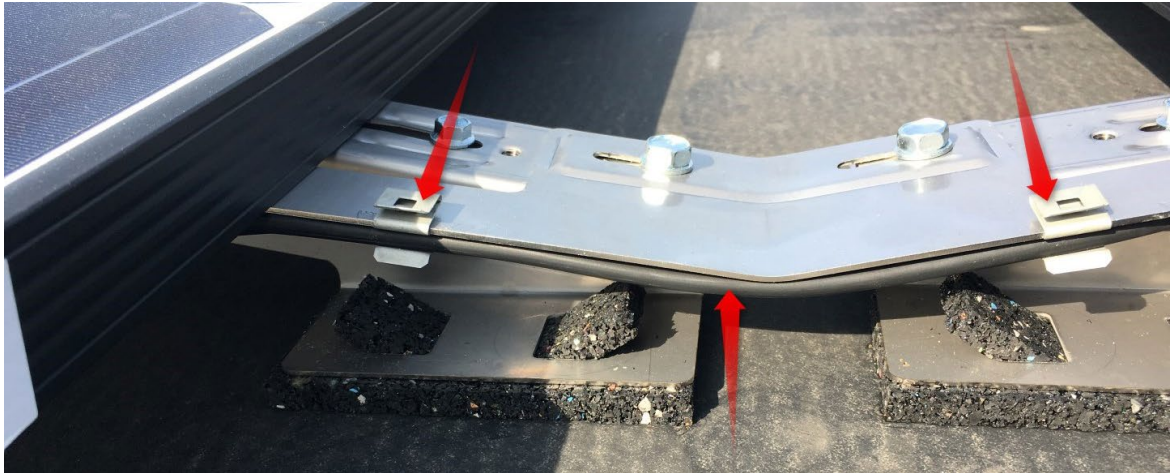
Abbildung 15: Korrekt befestigte DC-Verkabelung
