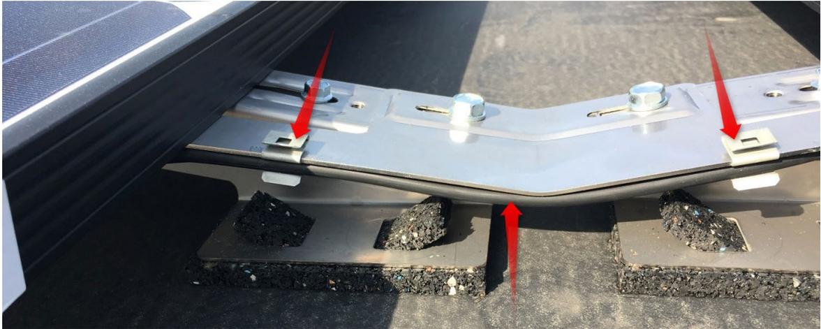
Abbildung 15: Korrekt befestigte DC-Verkabelung
