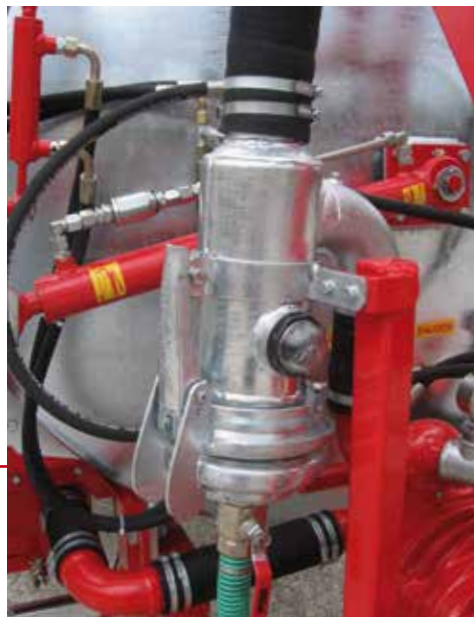
Siphon als standardisierter Schutz mit Ablasshahn und Schauglas.
